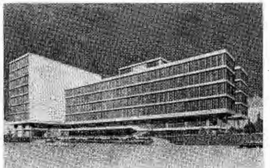
コンクリート造り・地上5階・地下1階・建坪2280坪
