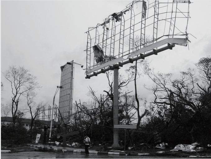
サイクロン・ナルギス被災翌日のヤンゴン。前日の暴風雨で街路樹が倒れ、大型看板は張り紙が吹き飛んで骨組みが折れ曲がった（2008年5月3日筆者撮影）。
