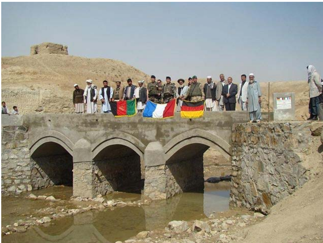
写真1 ISAFによる橋の建設事業
