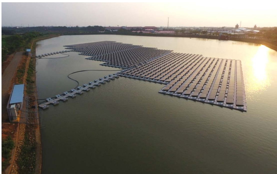
写真3 桃園市に位置するため池の水面型太陽光発電施設
