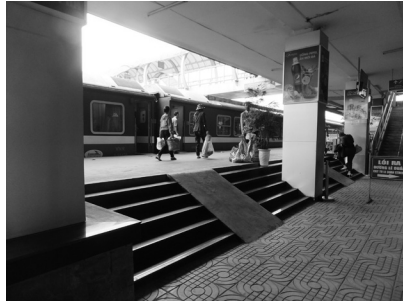
写真 3-3 ハノイ駅の高上げされたプラットフォーム。写真の右奥にある階段を上り、ほかのプラットフォームへ移動する (筆者撮影)
