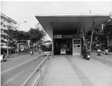
写真 3-11 BRTの正面 (筆者撮影)
