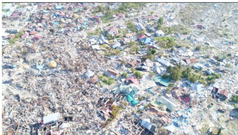
写真2 中スラウェシ州パルの被災後の様子
