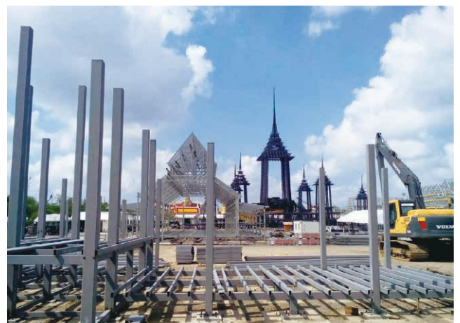
葬儀に使用する、周辺の建物も急ピッチで建設中
