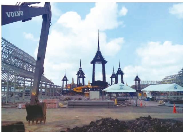
同じく建設途中のプラ・メルマート。黒々とした鉄骨が青い空に映えている
