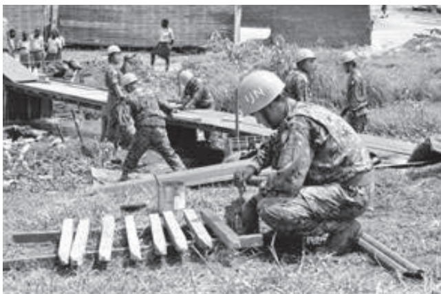
自衛隊による児童通学のための橋の設置作業 © 防衛省・自衛隊
