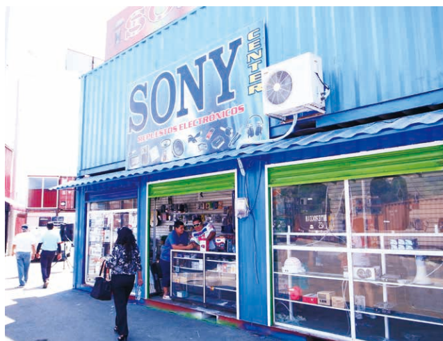
船積コンテナを利用し再開した電気店
