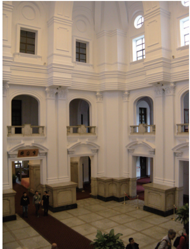
④玄関ホール（中山庁）。正門をくぐって階段を上ると、ここに到着する
