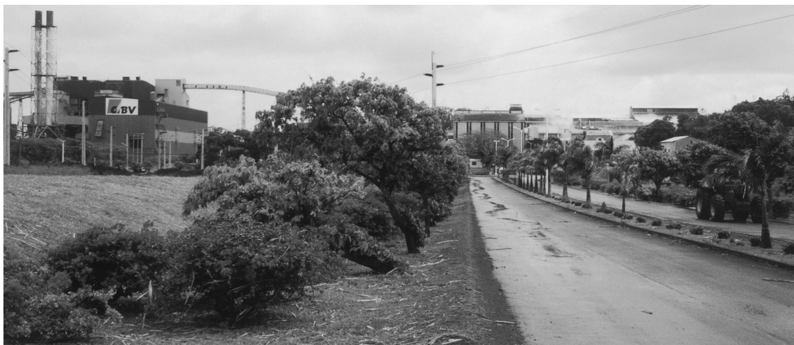
ベル・ヴィー製糖工場の外観——(正面および右側が製糖工場部門であり、1999年の砂糖生産量は26万6836トンで国内13工場中第5位、左側がサトウキビの搾りかす(Bagasse)を原料とする火力発電所、手前の道路脇には搬入途中にこぼれ落ちたサトウキビが散乱)
