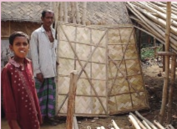
「ゴザ状のシート」に枠組みと支えを取り付けて「竹壁」のできあがり。これがスラムの家の壁になる(2000年撮影、BNP スラムにて)
