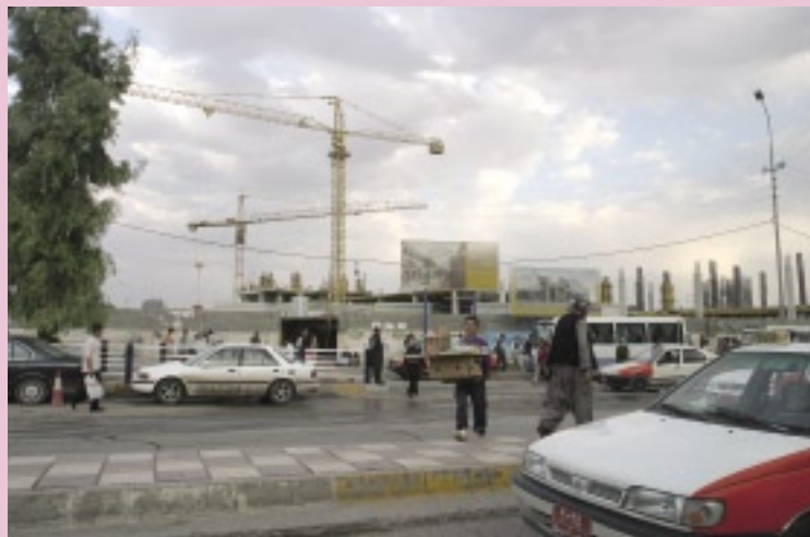
アルビルのショッピングモール建設現場
