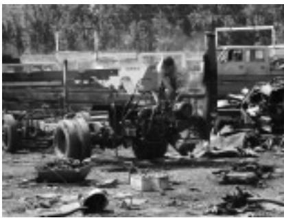
解体処理現場の作業風景（2007年5月26日、大連市、筆者撮影）
