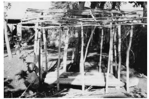
建設中のトイレ
