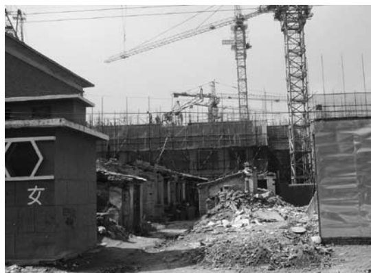
地方都市でも古い平屋の民家を壊して高層マンションを建築している。最近ではむしろ地方都市のほうが不動産価格の上昇率は高い(内蒙古自治区フホト市)
