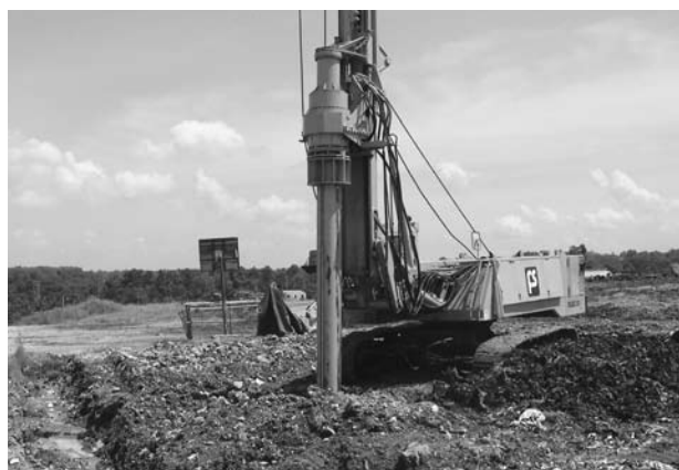
写真2 メタンガスの回収のためのパイプを埋め込む作業 (フィリピン・ケソン市、2007年8月、小島道一撮影)
