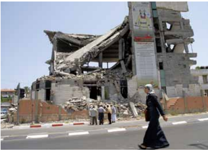
イスラエル軍に破壊された建物
