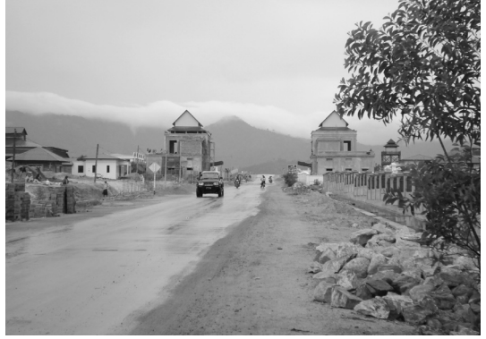
建設中のミャワディ国境貿易区。道路の右側が輸入検査ゲート。この道路はタイの経済協力で整備された（2008年8月26日、筆者撮影）
