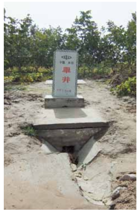
山西省中陽県暖泉鎮の旱井。雨水は傾斜をつけた溝を通して「旱井」の下に掘られた空洞に流れ込む
