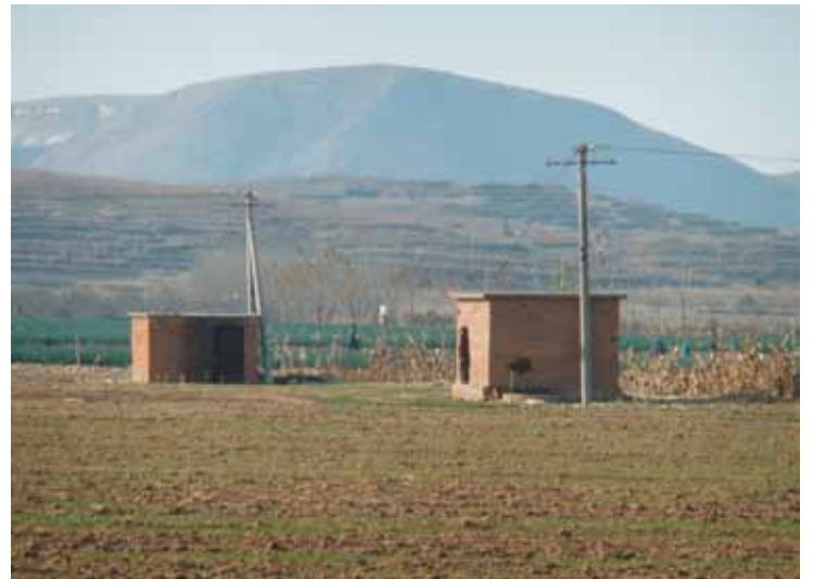
レンガ屋根で覆った井戸。この村では土砂の流入や事故を防ぐため集落に近い井戸に1980年代末に屋根をつけた。灌漑期には村人に開閉を行わせる
