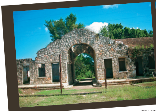
革命前の季節労働者の宿舎。これは入り口だが、両脇に20平米くらいの部屋が並ぶ。すでに屋根は落ち、遺跡のようである
