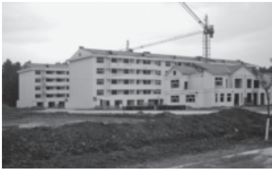
2. 建設中の村民むけ集合住宅。C村にはまだこのような動きはない（山東省濰坊市昌樂、2009年7月筆者撮影）
