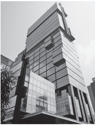
サニーの現地事務所は職住一体のアパートから一等地の新ビル42階へと「進化」した(筆者撮影)
