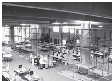
館内での足場組み
