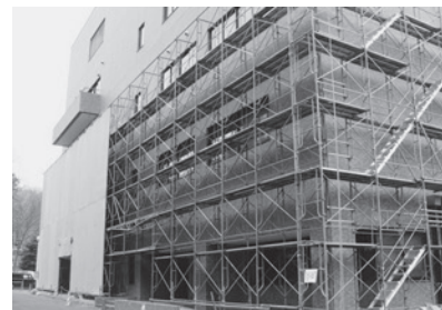
外壁補修のための足場組み
