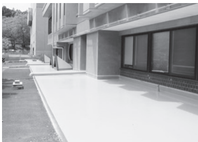
漏水工事が完了した地下書庫上部
