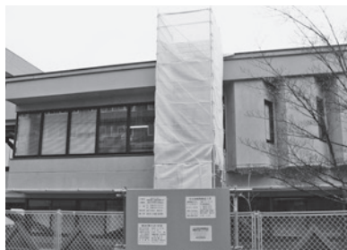
漏水対策工事
