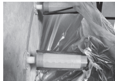
壁に注入する充填剤
