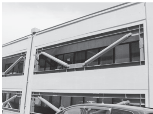
柱付き鋼管ブレース
