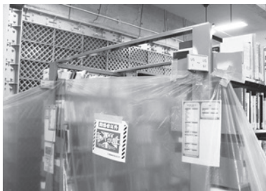
天井・壁の補修作業
