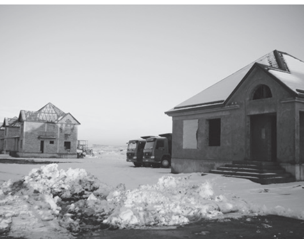
①シムケント市郊外のアサル地区。カザフ人移民のための住宅建設が進んでいた（2007年筆者撮影）
