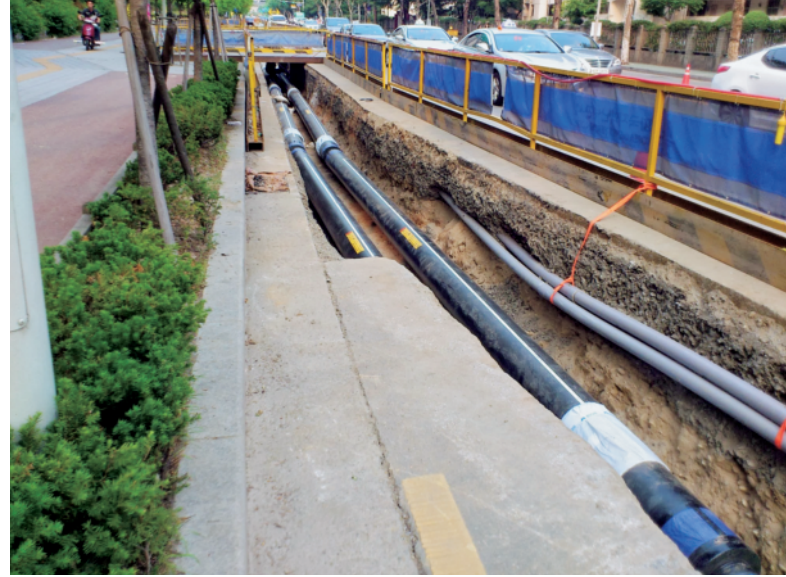
ソウルの大型アパート団地には地下の配水管を通じて韓国地域暖房公社からオンドル(床暖房)用の温水が供給されている
