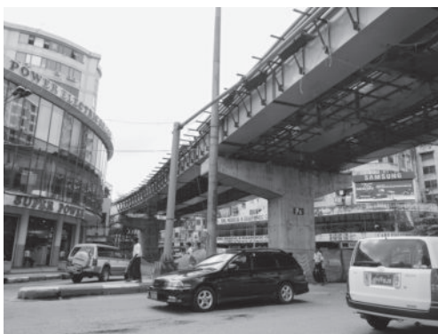
工事中のシュエゴンダイン交差点 (2013年12月開通 筆者撮影)
