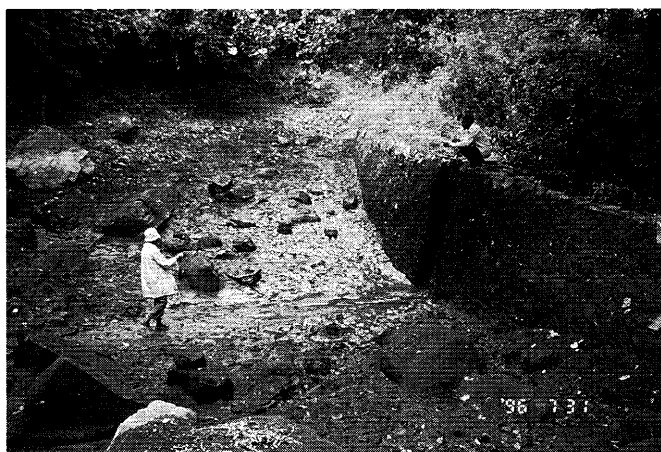
写真3 水を流し終わったムボゴ池。水門を閉め、翌朝まで10数時間水を溜める。
