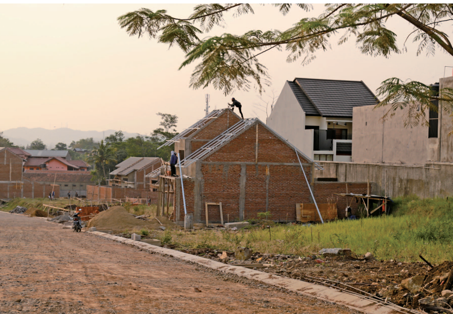
バンドン郊外ではいたるところで住宅建設が行われている
