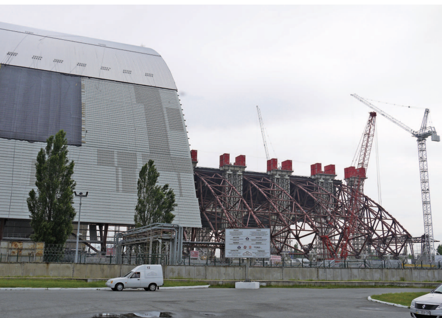
国際的な支援で建設中の「新石棺」。受注したフランス企業が莫大な利益を挙げている一方、現場のウクライナ人は高線量下で低賃金労働に従事させられているという話を聞いた
