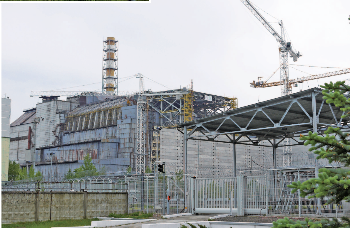
爆発した4号機を、こんなに間近に眺められるとは思わなかった。ソ連が設計開発した黒鉛減速沸騰軽水圧力管型原子炉（RBMK）のRBMK-1000型の原子炉が、人類史上最悪の事故を引き起こした
