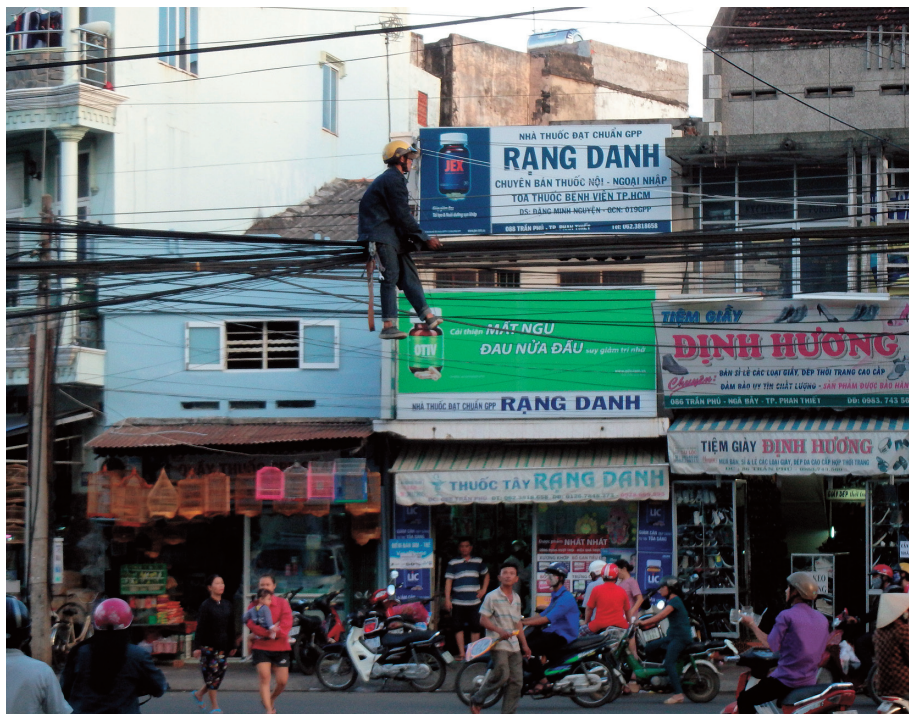
電線にまたがり作業をするおじさんがいた。集中しないと危ないので何の作業をしているのか聞くのは控えた
