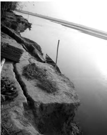
降雨により亀裂が入り、今にも崩れそうな川岸 (ラルモニルハット県、2010年筆者撮影)
