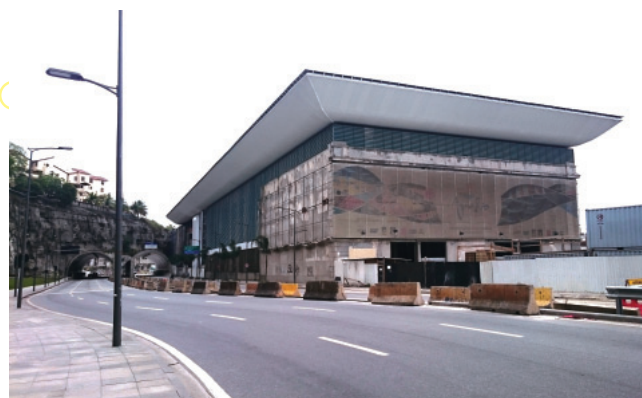
写真12 再開発が進む港湾地区にあり、完成すると南米で最大となる水族館。ただし2016年1月、工事中の水族館に強盗が押し入り、パソコンや工用具が盗まれる事件が発生した（同写真は2015年11月訪問時）
