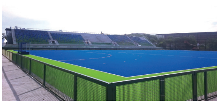
写真6 サブ会場となるデオドロ地区で試合が行われるホッケー場。コートはほぼ出来上がっていたが、観客席や周辺の施設はまだ工事中であった
