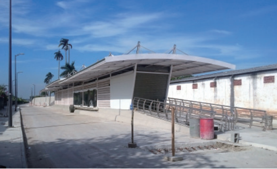
写真8 予定の6月までに完成させるべく工事が行われていた専用レーンバスBRTのトランスオリムピカ線デオドロ駅。メイン会場のバハ地区まで敷設され、当初予定では延長26kmだが若干の距離縮小になる見通し
