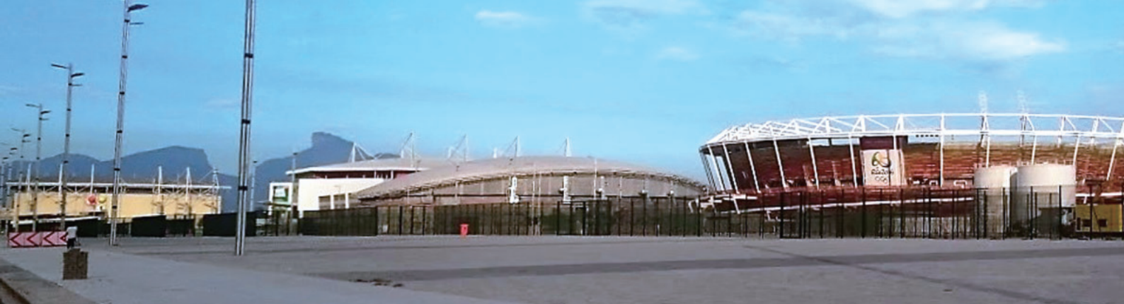
写真1 五輪のメイン会場となるバハ地区の競技施設。多くの施設が完成間近だったが、周辺の設備は工事中であり、テスト競技会で停電が発生するなどの問題も報じられた。
