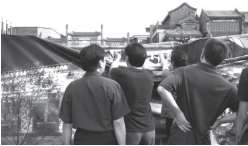
写真3 街中が完成予想図のシートで覆われた工事現場だらけだった
