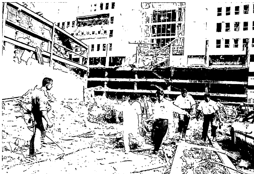
爆弾テロにより破壊された世界貿易センタービル(WWP)
