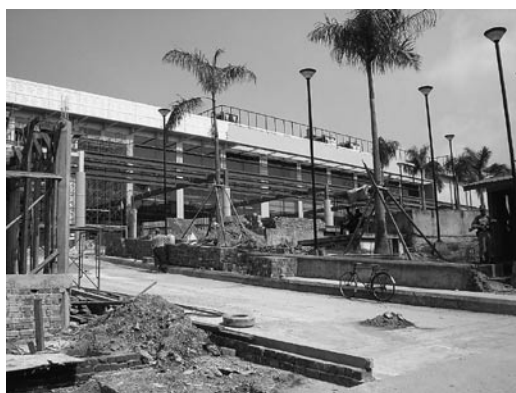
建設中の新ターミナル
