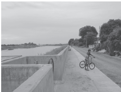
写真1 チャオブラヤー川沿いのコンクリート堤防 (2012年8月3日、中村撮影)
