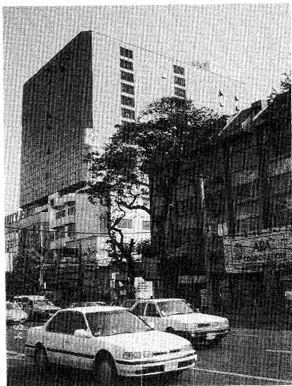
ビルラ・グループ9社が入っているマハト ン・プラザ・ビル（ブルーンチット通り）
