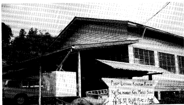
日本の援助を得て建設された村落開発研修センター
