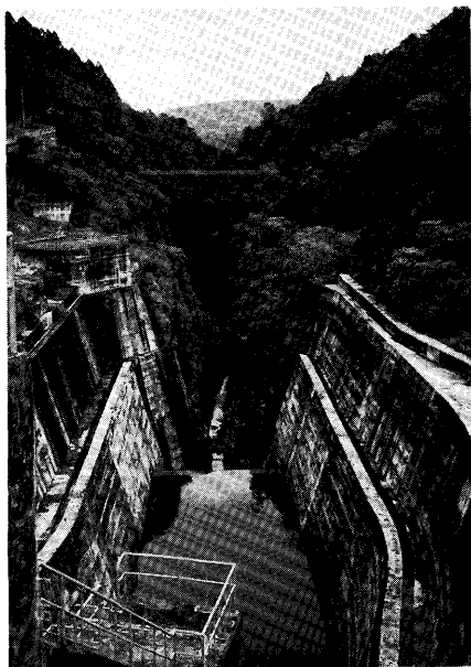
トバ湖からの水流を利用した発電所 主としてアルミ工場用に用いられる
