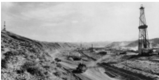
1950年代の玉門油田での坑井掘削風景。この掘削リグは中国製の初期標準タイプのもので、各地の油田現場で活動した（『中国石油産業 1949-1989』より）
