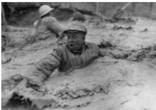
初期大慶油田の開発における「鉄人、王進喜」が坑井掘削に必要な泥水を身体でかきまぜる有名なシーンだが、この写真は「大慶石油会戦」の映画のスティール写真である（『中国石油産業 1949-1989』より）
