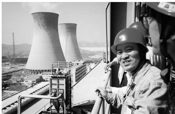
中国・鄭州市の石炭火力発電所
