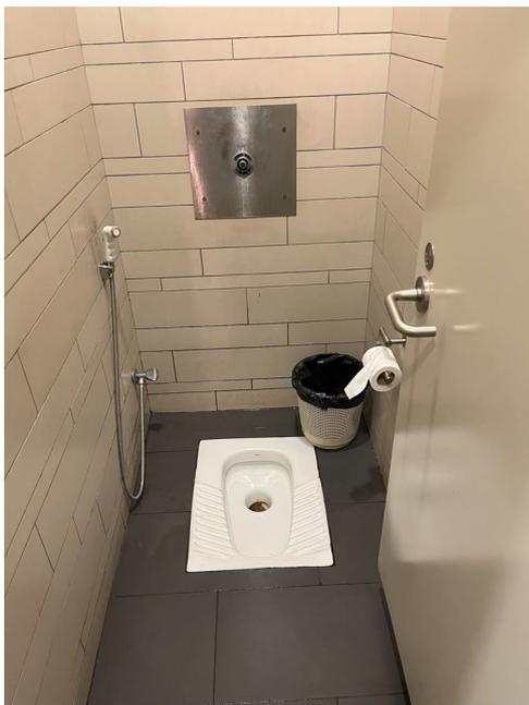
写真 1 2019 年に新キャンパスに移転したクウェート大学石油工学部新校舎内の最新のアラブ式トイレ。向かって左側壁面にシャッターが設置されている。全体的にトイレの洋式化が進んでいるとはいえ、新しい建物にも一定数のアラブ式トイレが設置されている (2023 年 11 月 27 日撮影)
