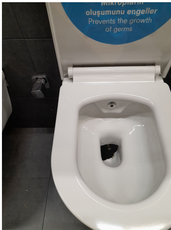
写真2 ホームセンターに展示されていたトイレの見本。日本のウォシュレットのノズル部分には水が出る出口がある。左のノブで水量調節（2023年11月20日）。
