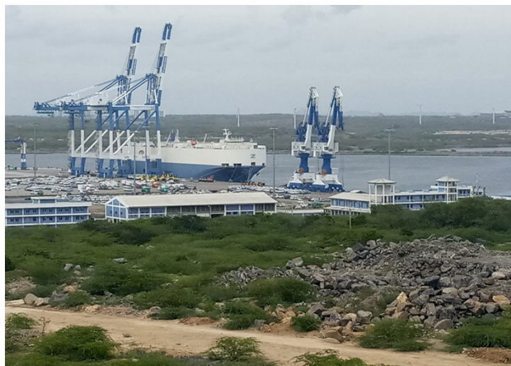
2017 年 9 月のハンバントタ港の様子。RORO 船から車両が積み下ろされている。クレーンは設置されているものの、RORO 船が主体であるため、ほとんど使用されていない (著者撮影)
