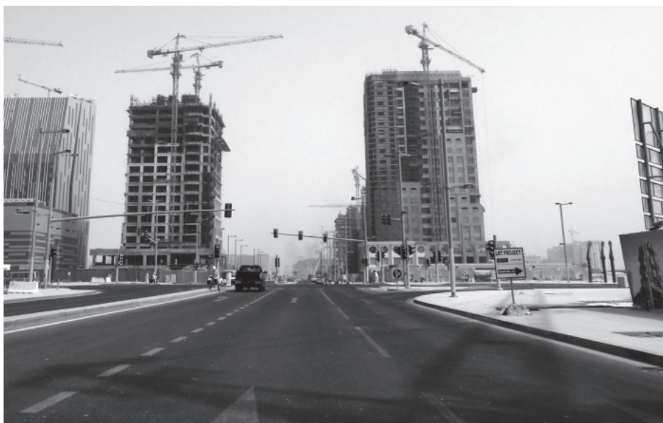
開発が進むドーハ北部のルサイル・シティ（筆者撮影）
