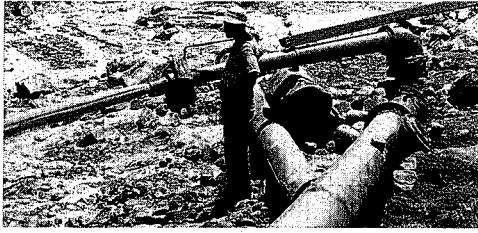
掘って、崩して……
