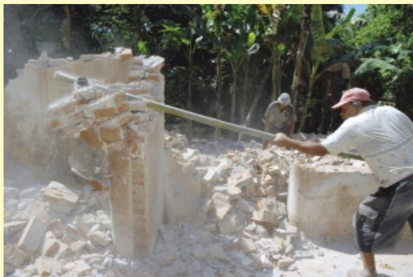
被災者が自ら、被災に遭った自宅を取り壊していた
