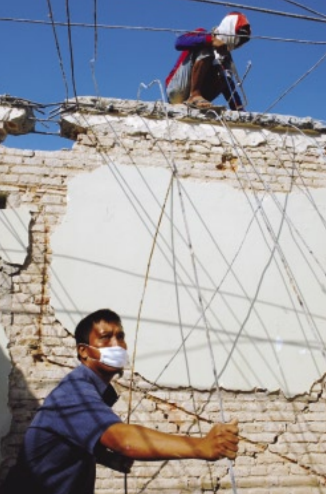
瓦礫の撤去作業は高度な作業機器が使われず、また素手で行われるケースが少なくはない
