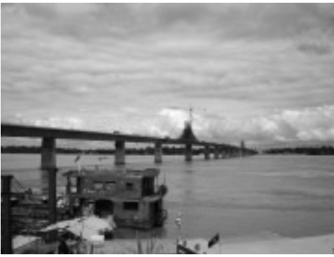
完成間近の第2メコン国際橋 (2006年8月27日、筆者撮影)
