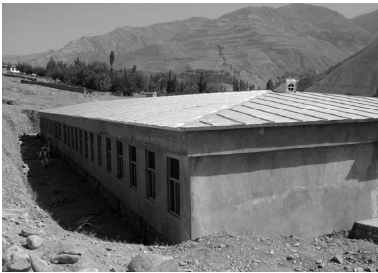
建設中のビビ・マリヤム女子校
