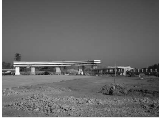
写真1：建設中の市庁舎（2006年12月6日、筆者撮影）
